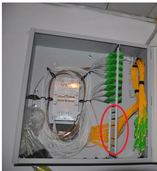
Rys.1. Wolne pola na ODF mogące pełnić funkcję pól parkingowych dla wtyków multipaczki PT
